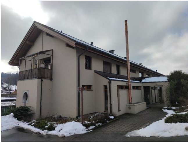
Neuer Kamin Gemeindehaus
